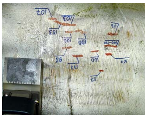
Рис.2. Второй объект контроля. Фрагмент стальной трубы толщиной 14мм. На поверхности видны области поверхностного стресс-коррозионного растрескивания
