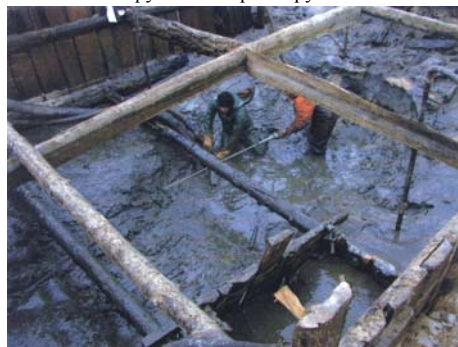
Рис.6. Разработка грунта в котловане
