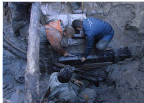
Рис.8. Дополнительный контроль шва с помощью X-32
