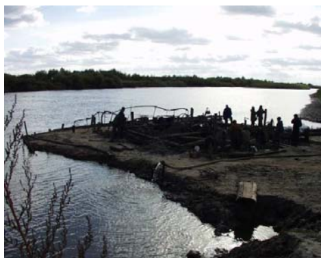
Рис.5. Намыв грунта по периметру котлована
